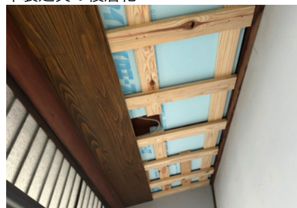
断熱性能を高める工事
