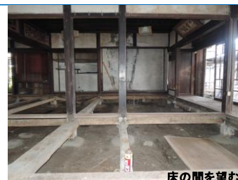
床の間を望む 床組み壁など解体作業中
